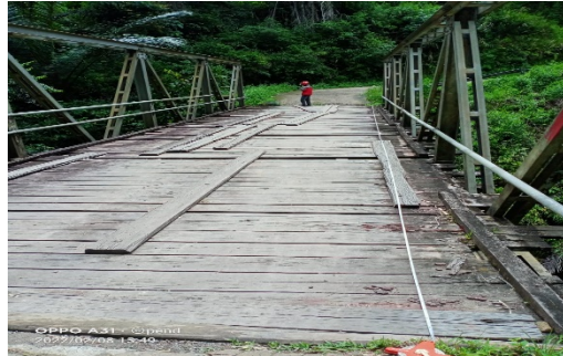
Gambar 2 Jembatan Sungai Sangpiak
