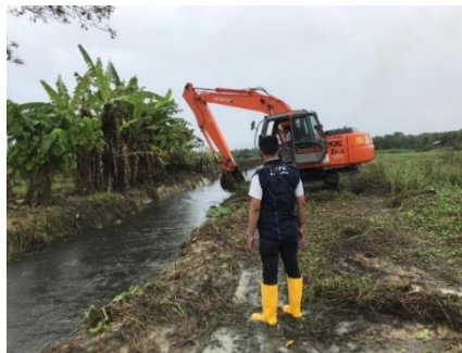
Gambar 5. Pengerukan Sedimen Sumber: Anonim, 2021
